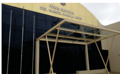
Fórum Eleitoral - Des. MANOEL CACELIA ALVES Santarém (Reforma e Ampliação) Área construída: ampliação de 506 m 2 para 907 m 2 Reinauguração: 2016 Endereço: Avenida Mendonça Furtado, 2039 20ª, 83ª e 104ª Zona Eleitoral: Santarém Valor da Obra: R$ 930.321,69
