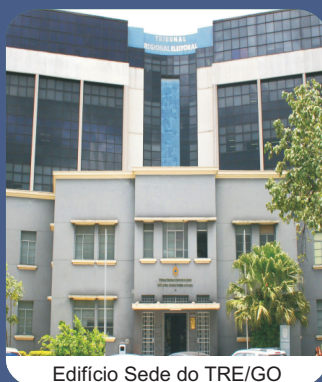
Edifício Sede do TRE/GO
