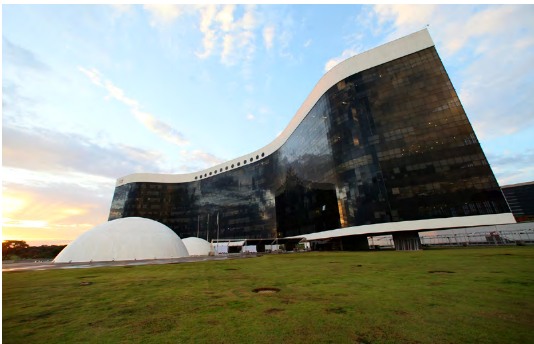
7º Edifício-Sede do TSE Setor de Administração Federal Sul (SAFS), Brasília/DF. Atual sede. 2011 Museu do Voto (TSE)
