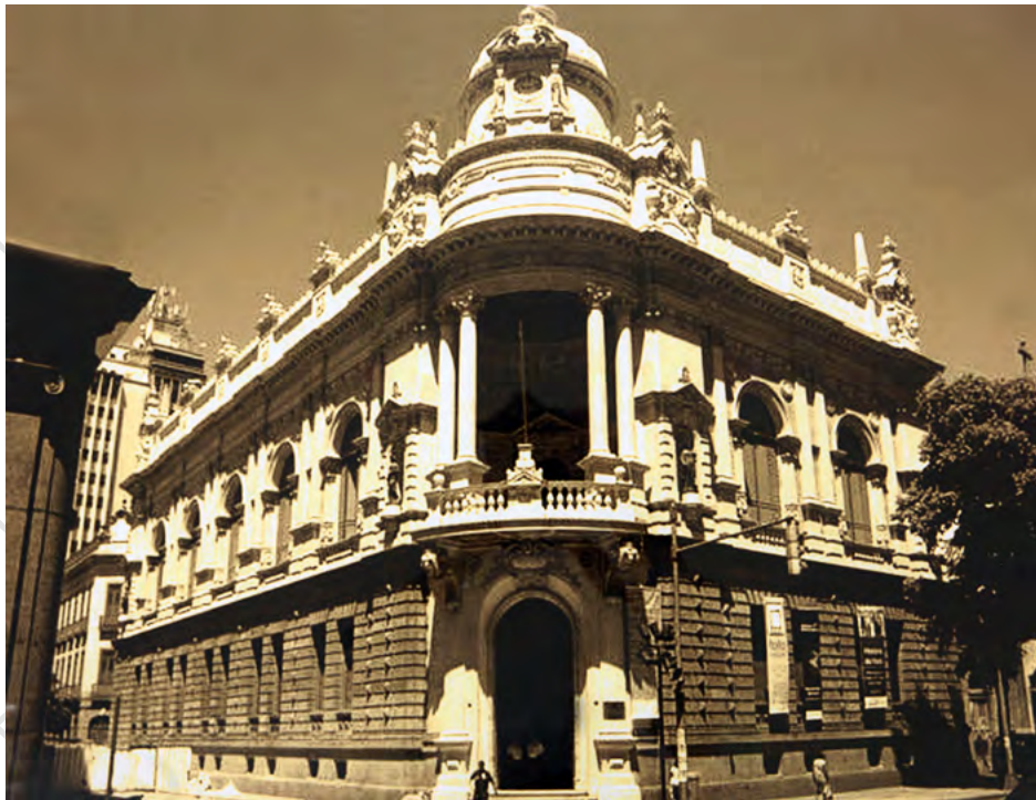
4º Edifício-Sede do TSE Rua 1º de Março, Rio de Janeiro/RJ. 1946-1960 Museu do Voto (TSE)
